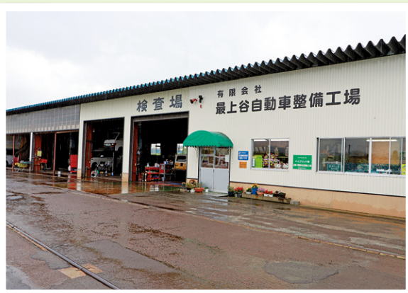
最上谷自動車整備工場
